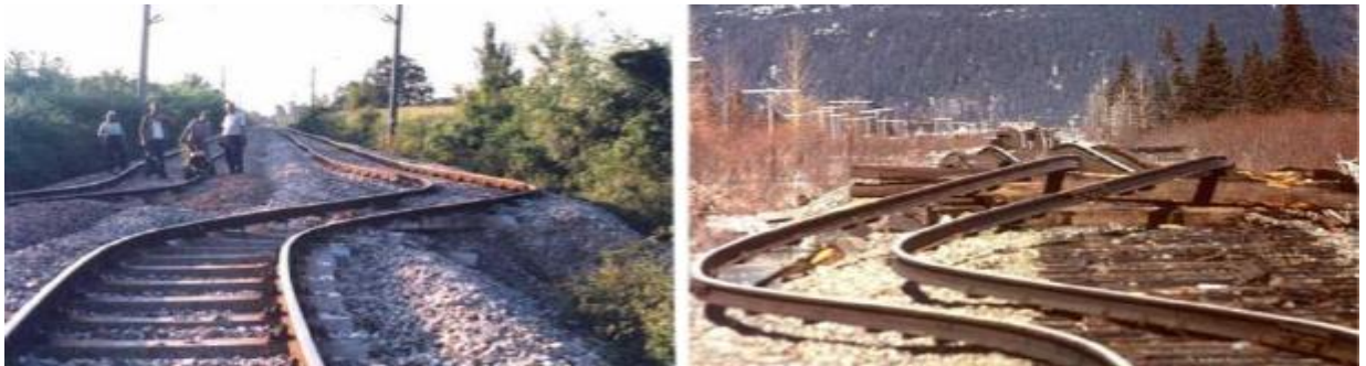
3-rasm. Turkiya va Alyaskadagi zilzilalar paytida temir yo'l relslarining L to'liqlari bilan deformatsiyasi
