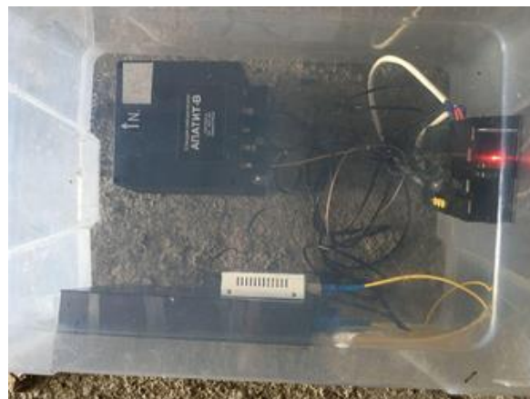
Рис. 3. Комплектация установленного оборудования
