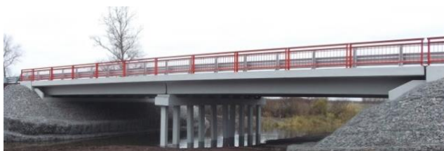
Рис. 1. Общий вид двухпролетного железобетонного моста
