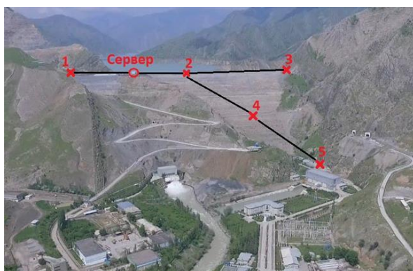
Рис. 4. Схема расположения сейсмологической системы.
